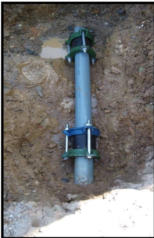
Reparación en tres tramos de la tubería de distribución en el Barrio Pichincha
